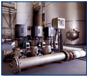
Ус цэвэршүүлэх төхөөрөмжийн насос Water treating equipment pump
